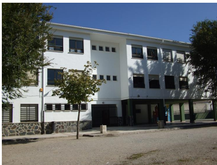
Ilustración 1: Fachada del Colegio Andalucía
